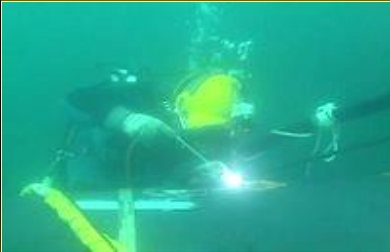
svařování pod vodou
